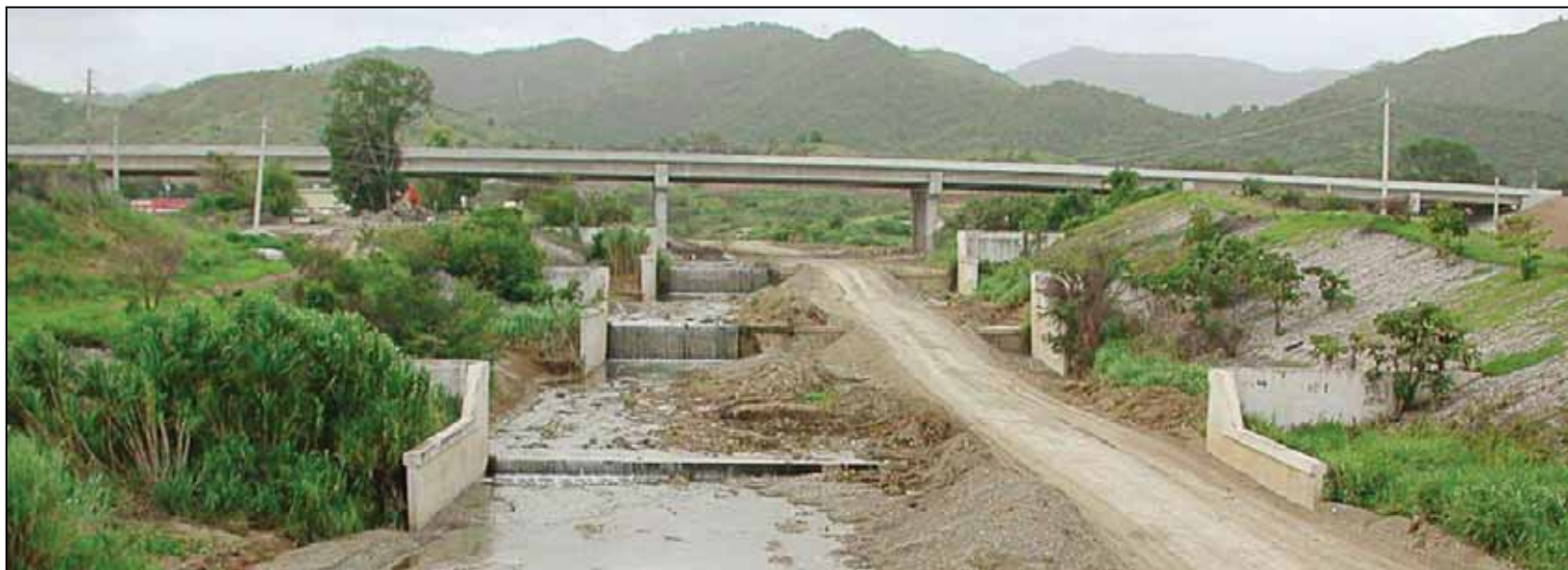
Ilustración 9.15: Obras de limpieza de canalización en Ponce.
