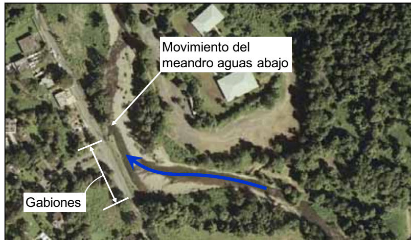
Ilustración 10.11: Localización del talud erosionado.
