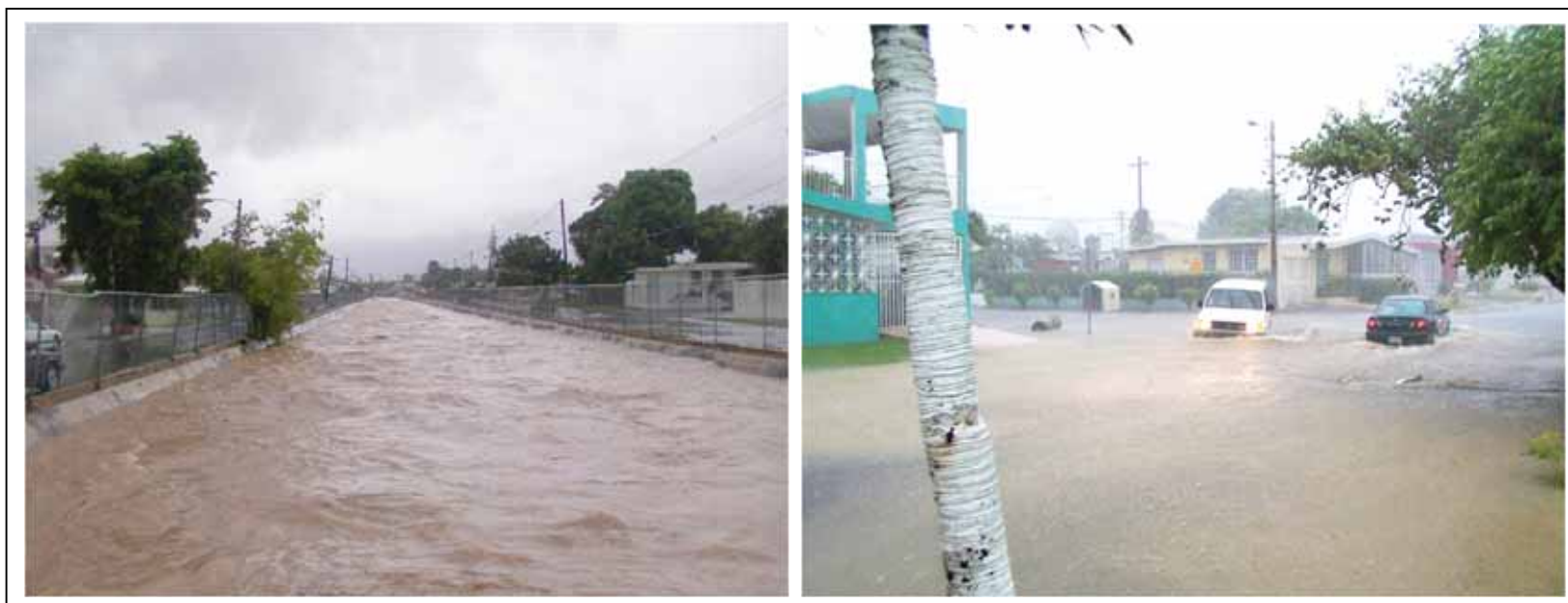
Ilustración 9.16: Canalización de la Quebrada Blasina en Carolina al punto de desborde, 2002. El nivel elevado en el canal reduce la capacidad hidráulica de las tuberías pluviales provocando inundaciones aun sin haberse desbordado el canal.
