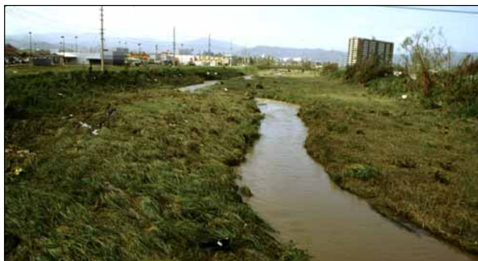
Ilustración 9.19: Canalización en el Río Humacao luego del Huracán Georges (1998). La crecida no removió los sedimentos previamente depositados y cubiertos de vegetación.
