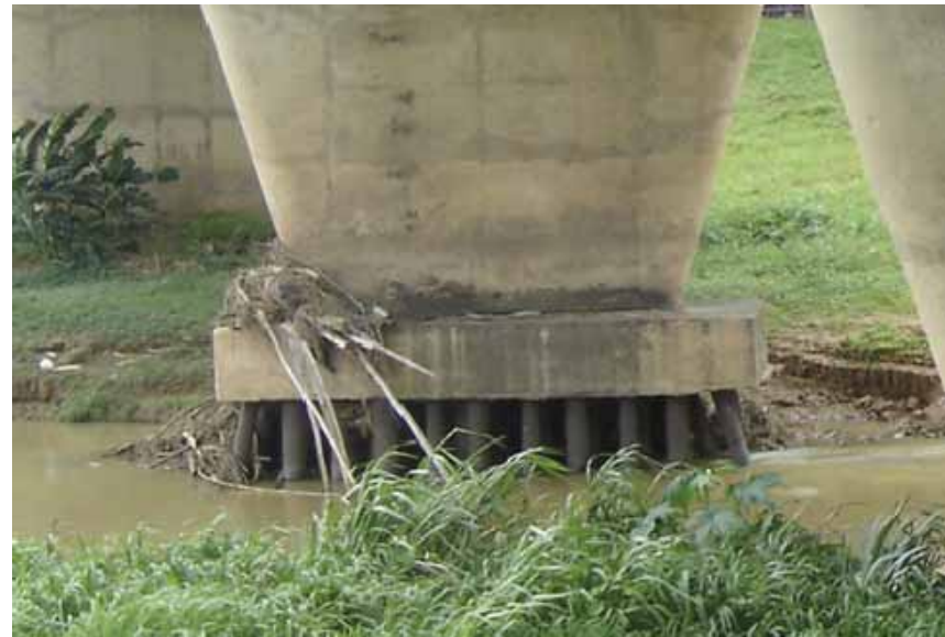
Ilustración 3.4: Pilas-tras expuestas del puente de la PR-22 en Bayamón.
