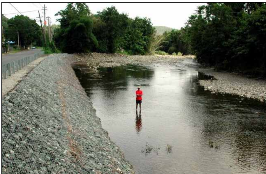
Ilustración 10.13: Gaviones instalados para protección de talud en Río Mameyes, junio 2000.
