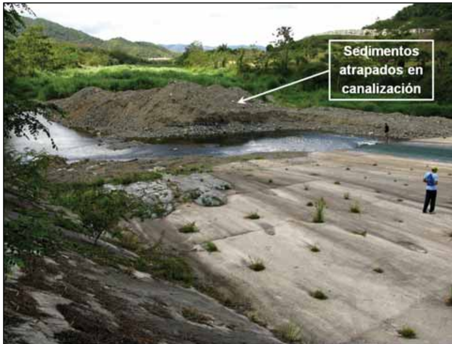
Ilustración 9.20: Acumulación de sedimentos en la canalización del Río Turabo.
