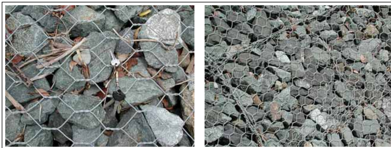
Ilustración 9.5: Gaviones recién instalados.
