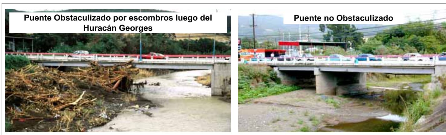
Ilustración 9.22: Puente sobre Río Guayanilla.
