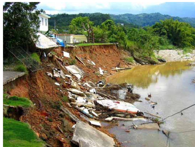
Ilustración 3.13: Casas en Urbanización Villa del Rey destruidas por migración de meandro en Río Turabo.
