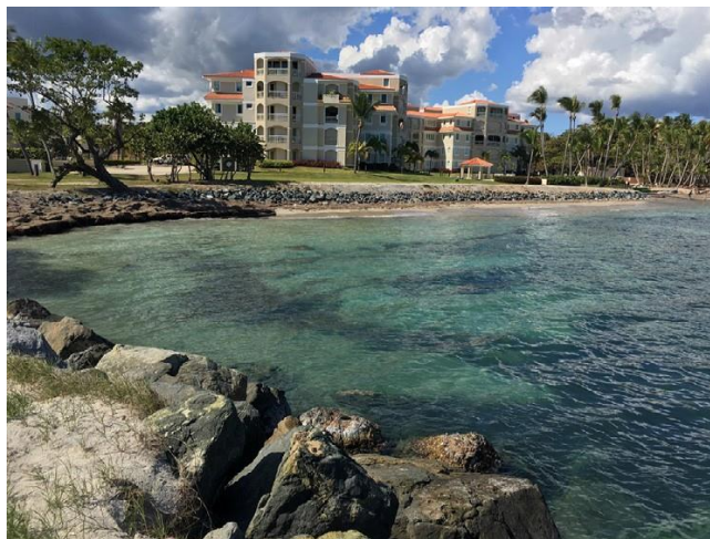
Proyecto de protección litoral en la Plaza del Mar, Palmas del Mar, Humacao. Foto tomada en enero de 2017 (antes del huracán María).
