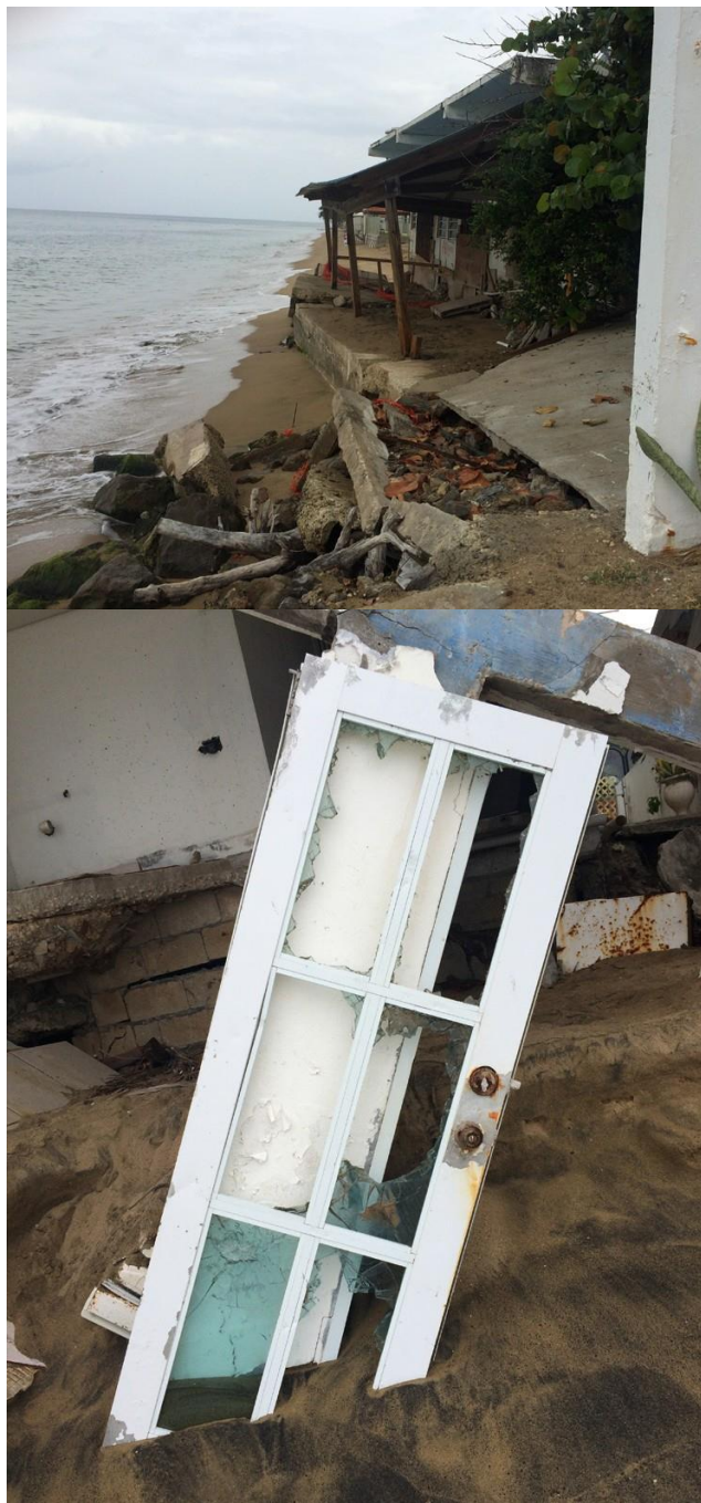
Viviendas abandonadas pos-desastre y escombros costeros. Fotos: DRNA
