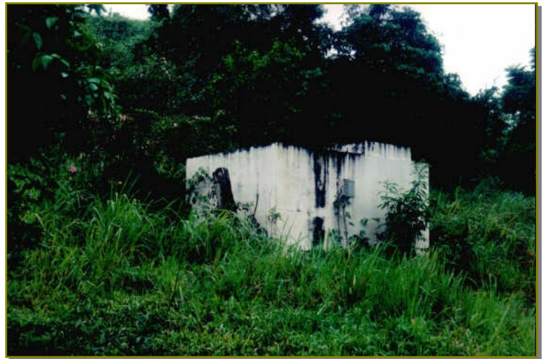
Foto 8: Vista de la cisterna que se utilizaba para almacenar agua.
