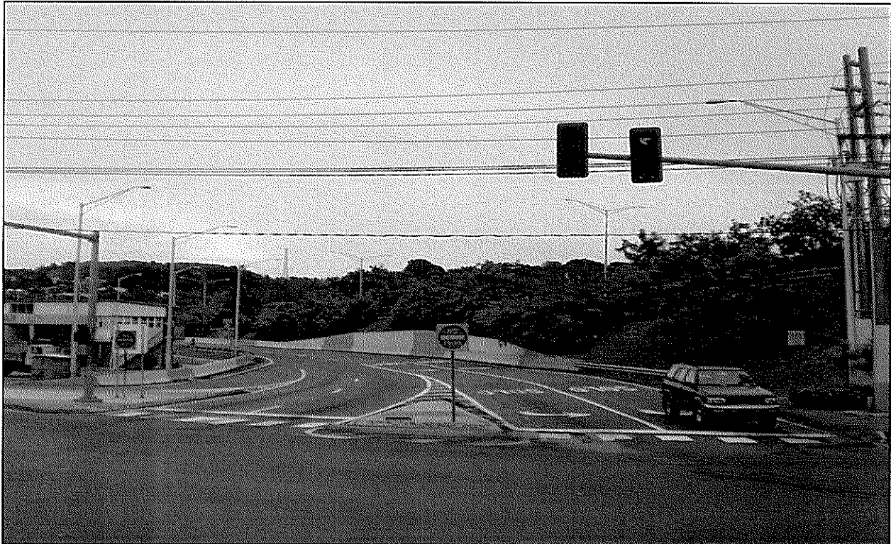
Foto 30: Intersección Carreteras PR-169, PR-834 y Rampa PR-20, acceso este
