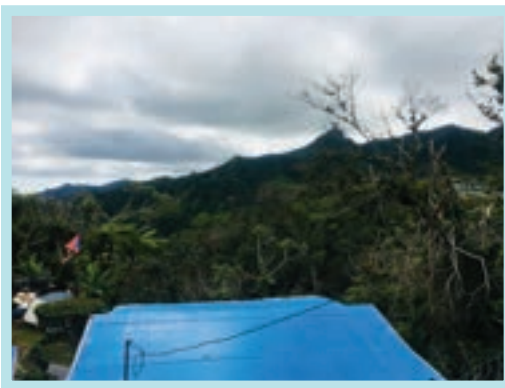
Casas que perdieron sus techos, con toldos temporeros Créditos: Dayani Centeno Torres
