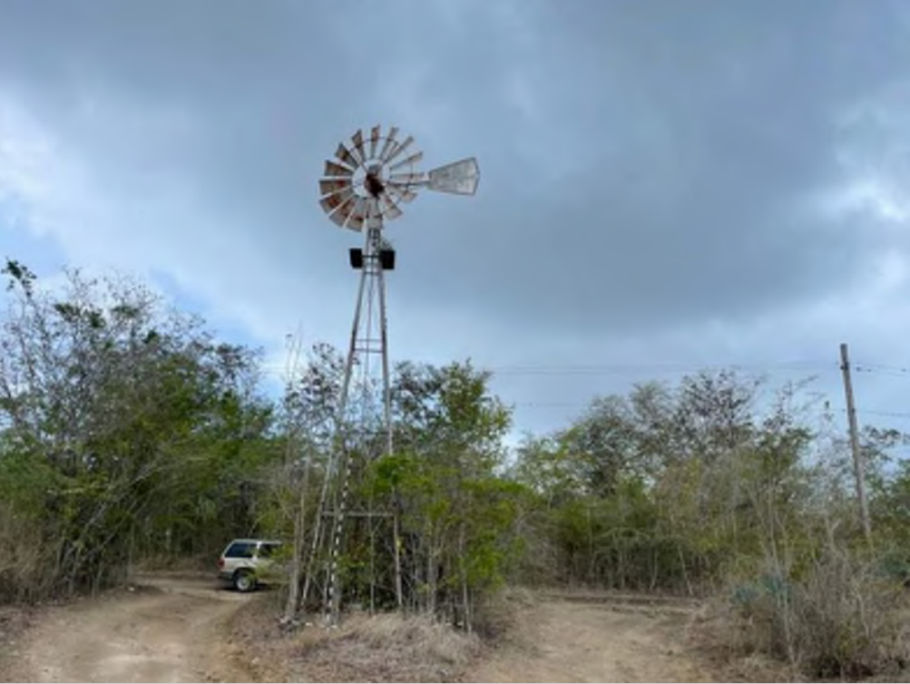
H-3 - MOLINO DE VIENTO PARA EXTRACCIÓN DE AGUA
