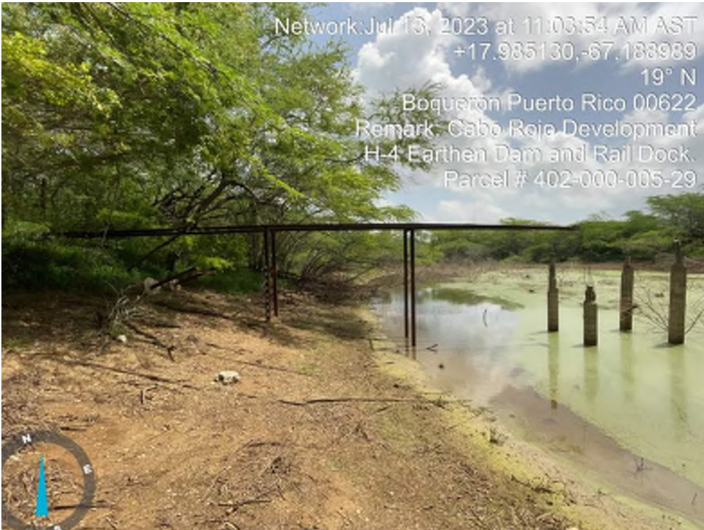
H-4 - MUELLE CONSTRUÍDO CON RIELES HISTÓRICOS DE TREN
