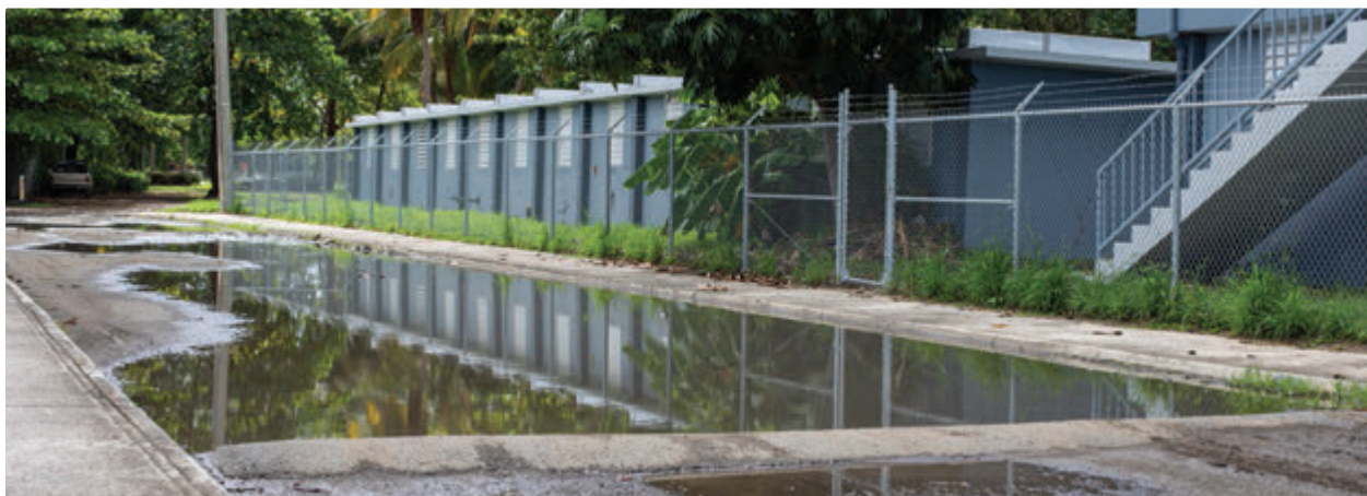
Acumulación de agua y deficiencias en la infraestructura vial costera, limitando la funcionalidad y el mantenimiento adecuado del acceso.
