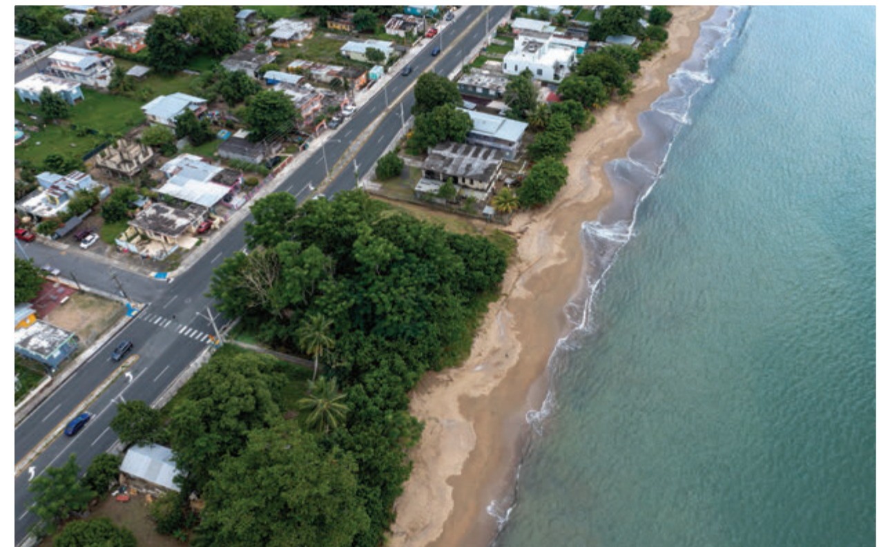
Corredor paralelo que conecta diversos accesos a Playa Sabanetas, estructurando la accesibilidad costera del sector.
