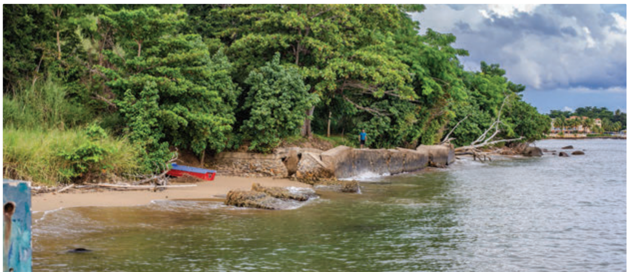
Escombros costeros asociados al antiguo trazado de la vía del tren en el acceso a la playa La Pared.
