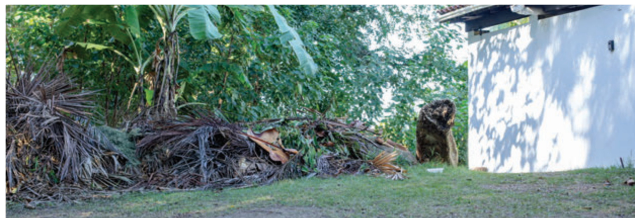
Acumulación de escombros en el acceso.
