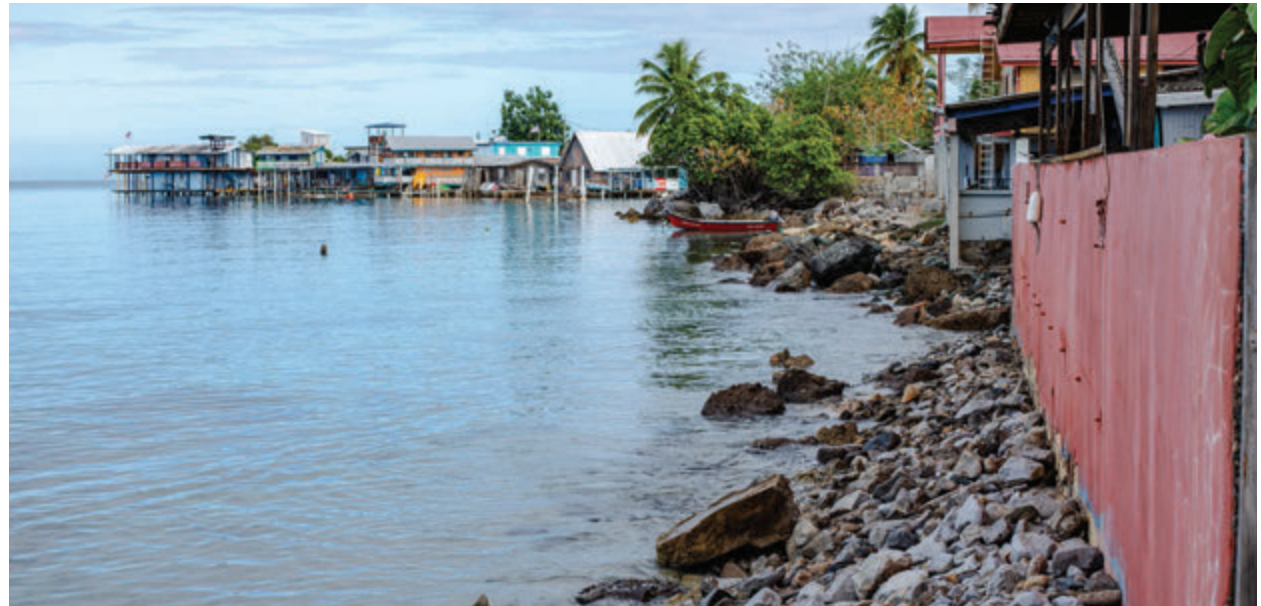
Revestimientos informales que buscan atender la erosión costera, fragmentando la accesibilidad paralela.
