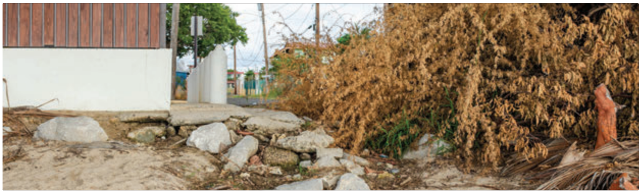
Transición del acceso a la costa obstaculizado por procesos de erosión asociado a escorrentías pluviales.
