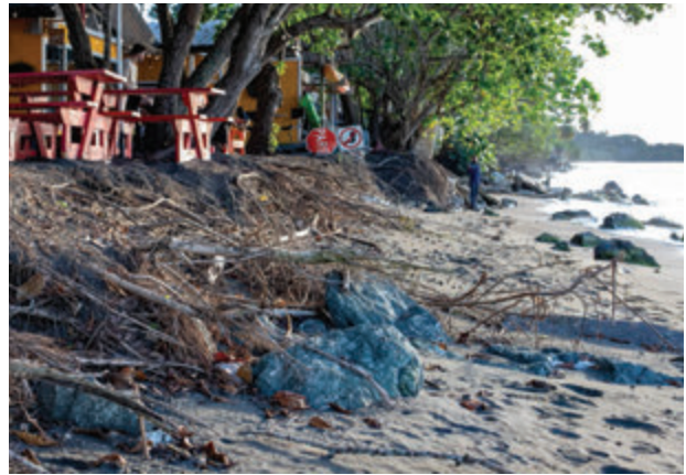
Erosión costera, Restaurante Carbón de Palo, Bo. Guanajibo.
