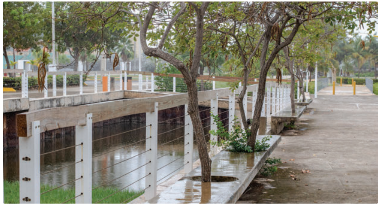
Infraestructura de bancos en el Paseo del Litoral asociada al acceso costero, facilitando espacios de descanso y encuentro dentro del corredor urbano marítimo.
