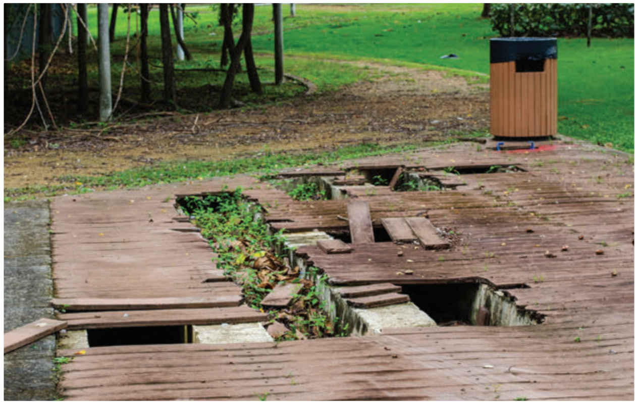
Infraestructura pesquera deteriorada que compromete la seguridad y la funcionalidad del acceso dentro del sistema costero urbano.
