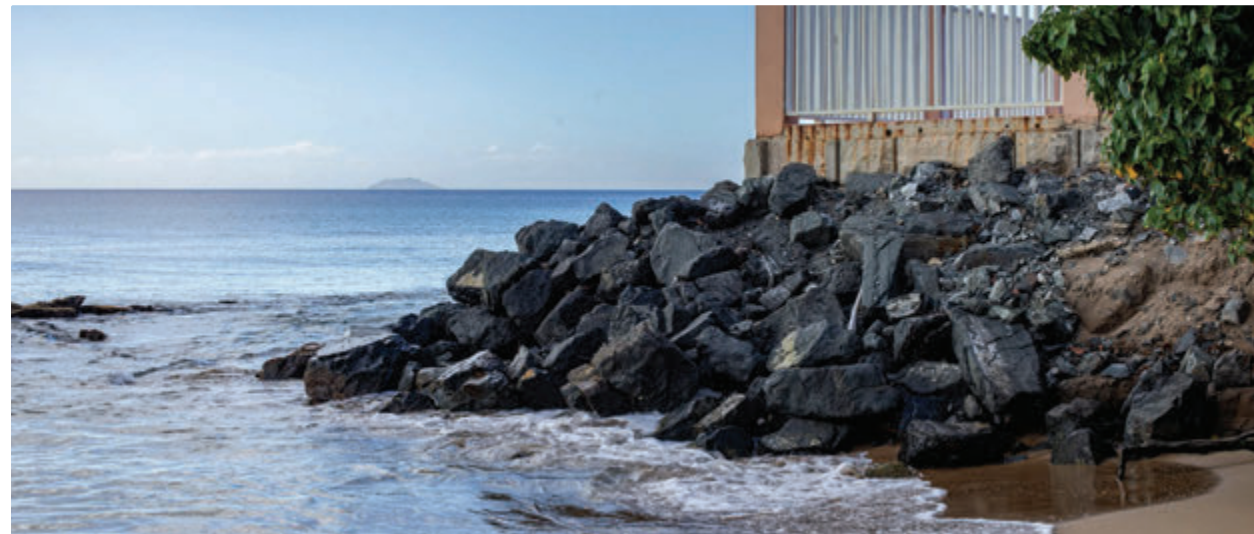
Revestimiento de piedra informal que limita la accesibilidad paralela interrumpiendo el corredor costero.
