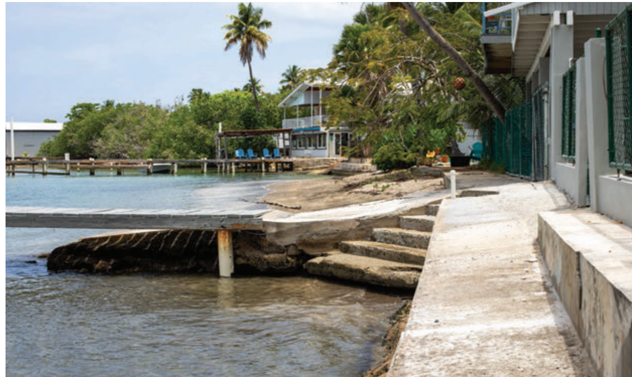
Obstaculización que se repite a lo largo de la costa de Joyuda fragmentando la accesibilidad paralela a la costa.
