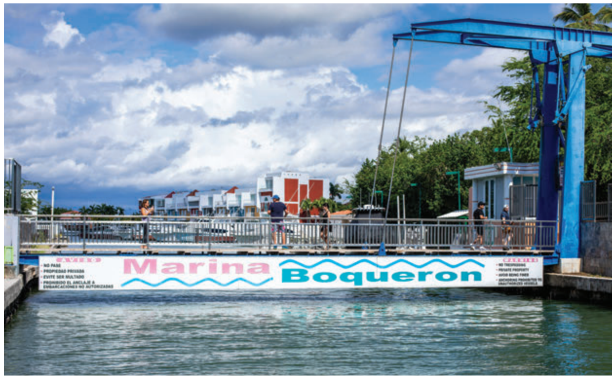
Puente elevado que conecta el acceso peatonal desde el poblado de Boquerón hasta el balneario.
