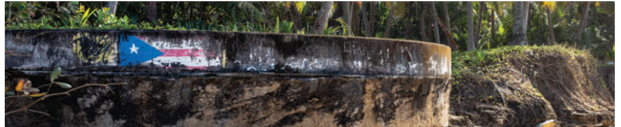
Estructura circular en hormigón asociada a antiguas posiciones de artillería costera en Aguada.
