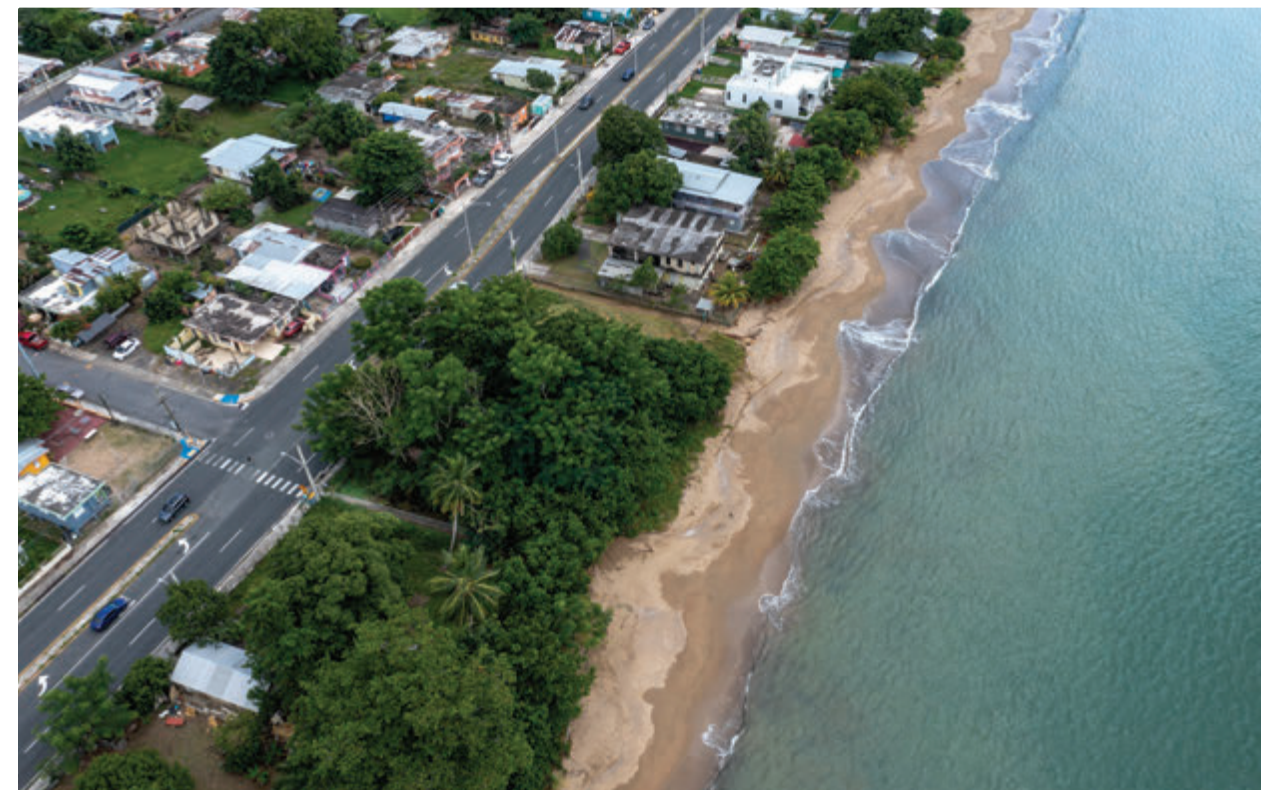
Corredor paralelo que conecta diversos accesos a Playa Sabanetas, estructurando la accesibilidad costera del sector.
